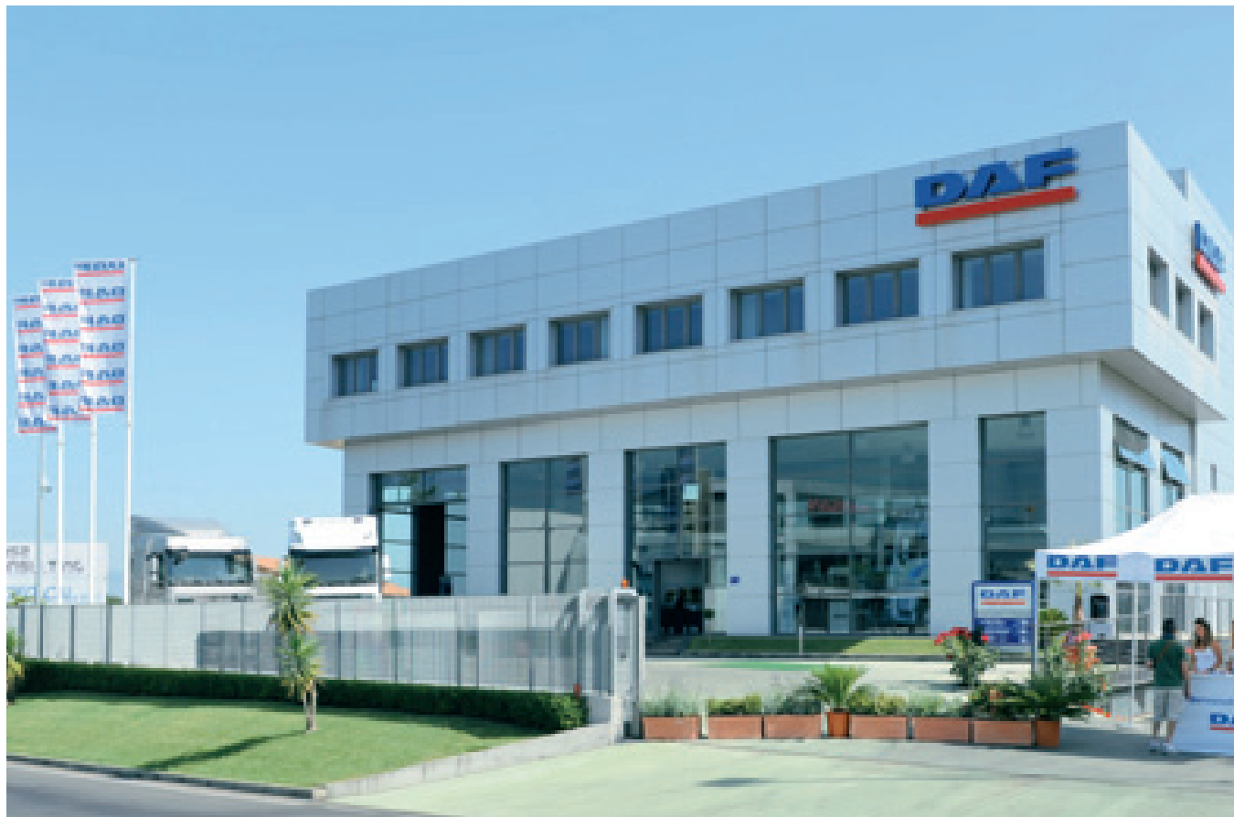
La nuova sede unica della Delcom a Rende, in provincia di Cosenza, si estende su un'area complessiva di 20mila metri quadrati.
