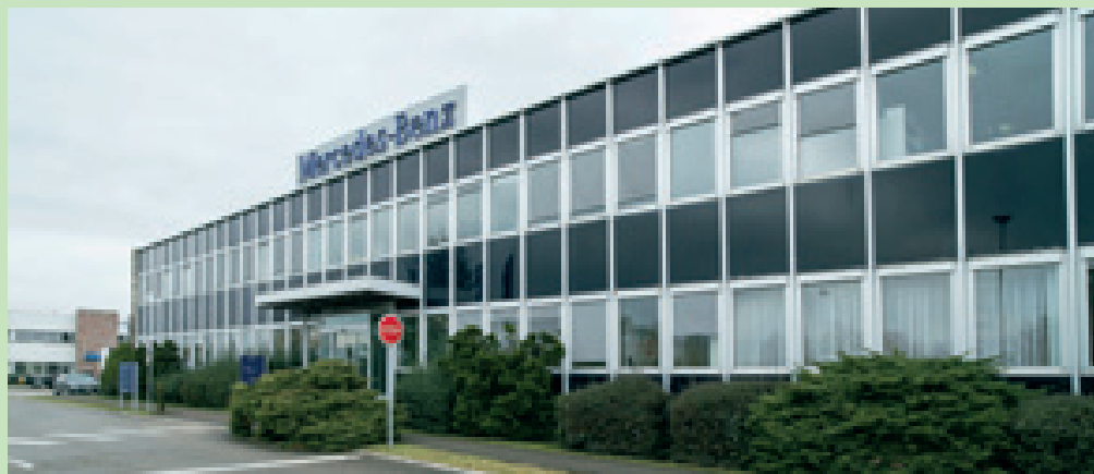
Uno degli edifici del complesso industriale di Molsheim dove ha sede la divisione CTT di Mercedes-Benz.
