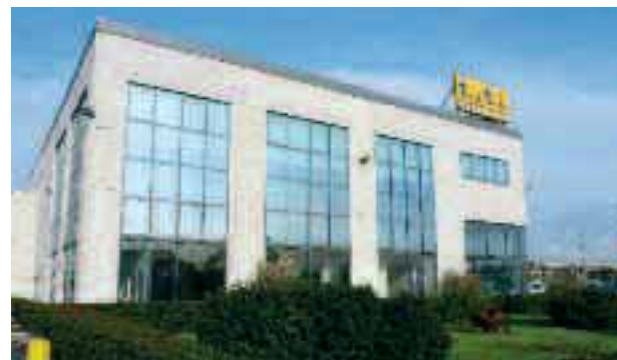
La sede della T.&T.I. Cargo Line a S. Giuliano Milanese ricavata da una precedente struttura di Renault Trucks Italia.
